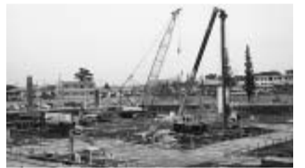
建設工事が進む新市立病院
