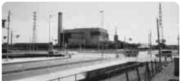
東埼玉道路の側道から見た第二清掃工場
