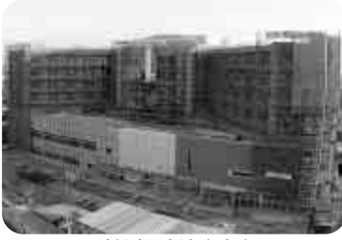
建設中の新市立病院
