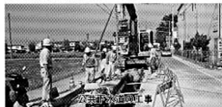
公共下水道の工事
