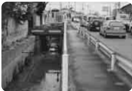
改修が望まれる河内堀
