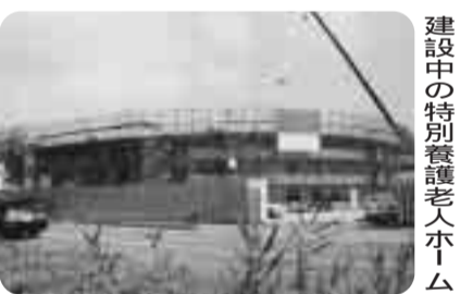
建設中の特別養護老人ホーム
