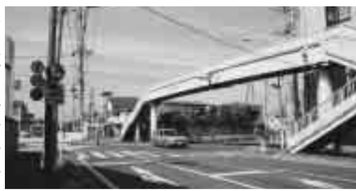
松戸草加線交差箇所
