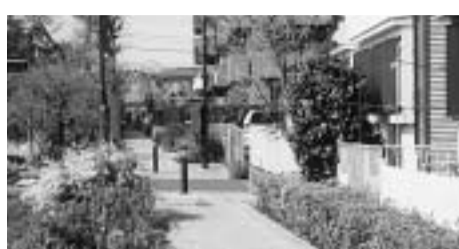
歩道化された水路敷
