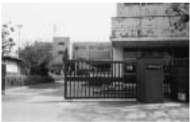
改築中の川柳小学校
