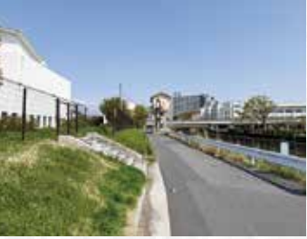
辰井川排水機場南側
